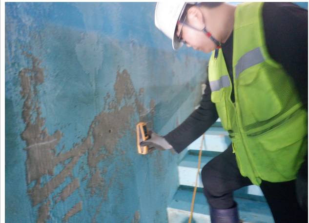
탄산화 깊이 측정
