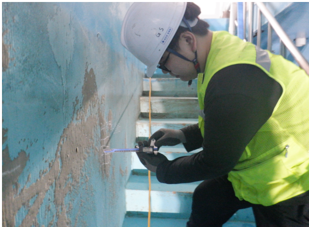
탄산화 깊이 측정
